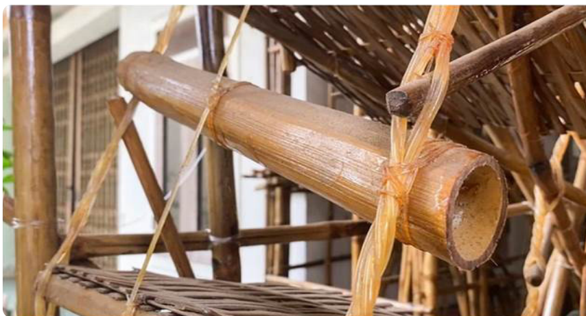
Hình 31. Ống tre để lấy nước khi bánh xe quay
